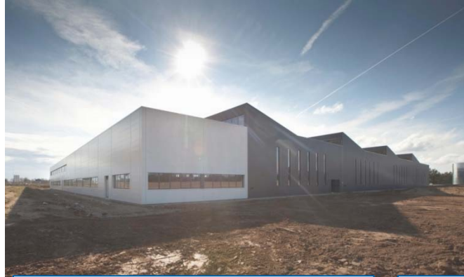
Labinal à Villemur (France) Câblages aéronautiques
