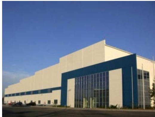
Snecma à Queretaro (Mexique) Maintenance et réparation de moteurs
