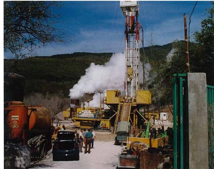
Réalisation d'un puits producteur et d'un puits injecteur de diamètres successifs de 26" (350 m) 17"1/2 (350-1100 m) 12"1/4 (1100-1800) 8"1/2 (1800-2000), déviés à 30°.
